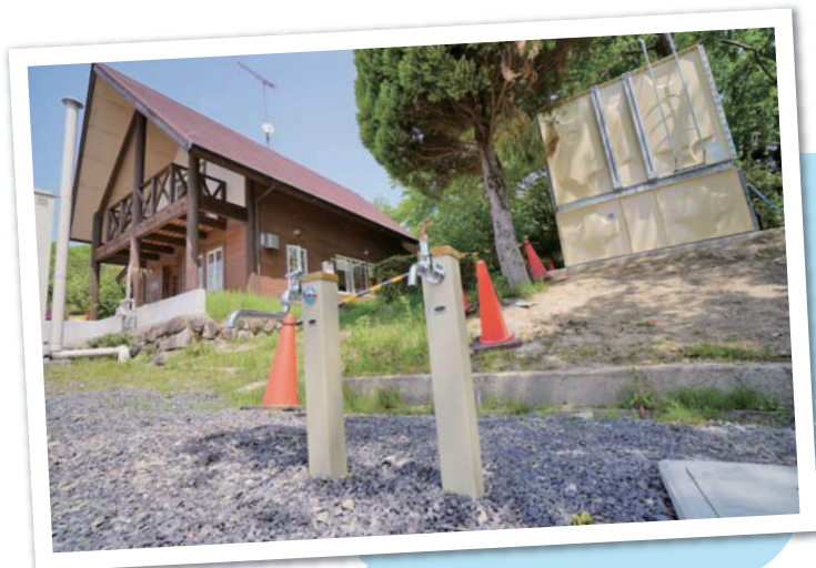
地下水は一旦貯水槽に溜められ、手前にある2つの蛇口から配水されます。
